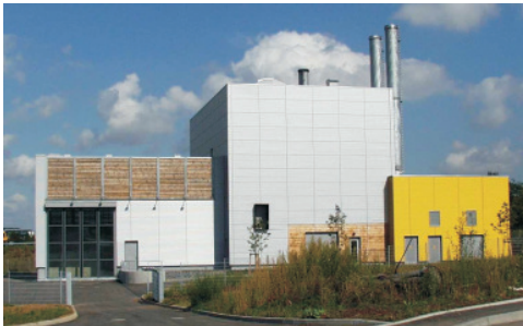
② Biomasseheizwerk mit ORC-Anlage Carl-Zeiss-Straße 6
